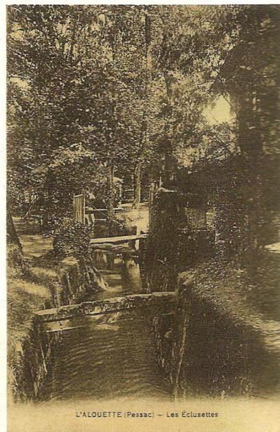
Les Éclusettes sur le Peugue (ancien système de retenue des eaux)
